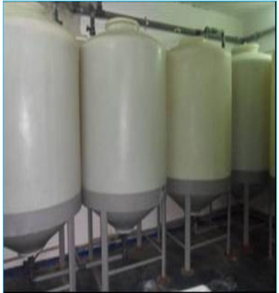
Les Cuves de collecte des effluents liquides radioactifs.
